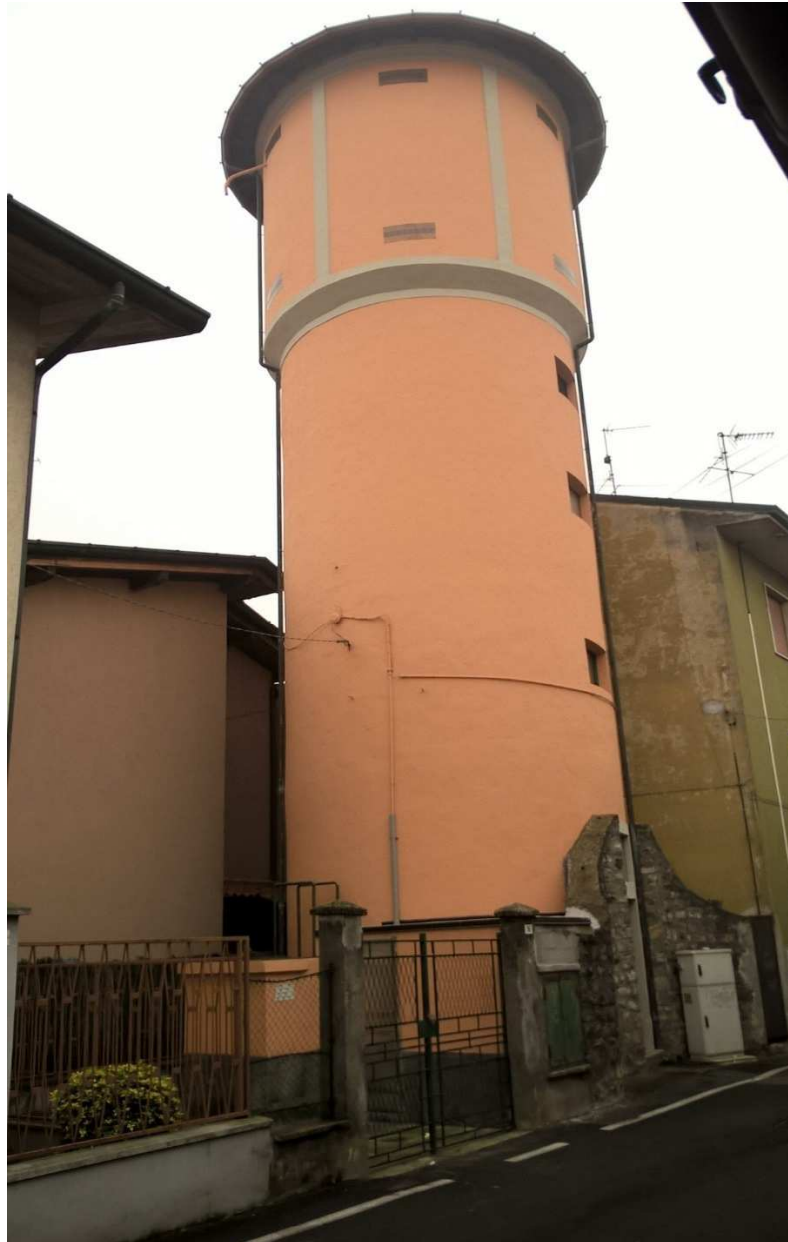
Foto 1 – Fine lavori ristrutturazione serbatoio Pace a Rudiano
