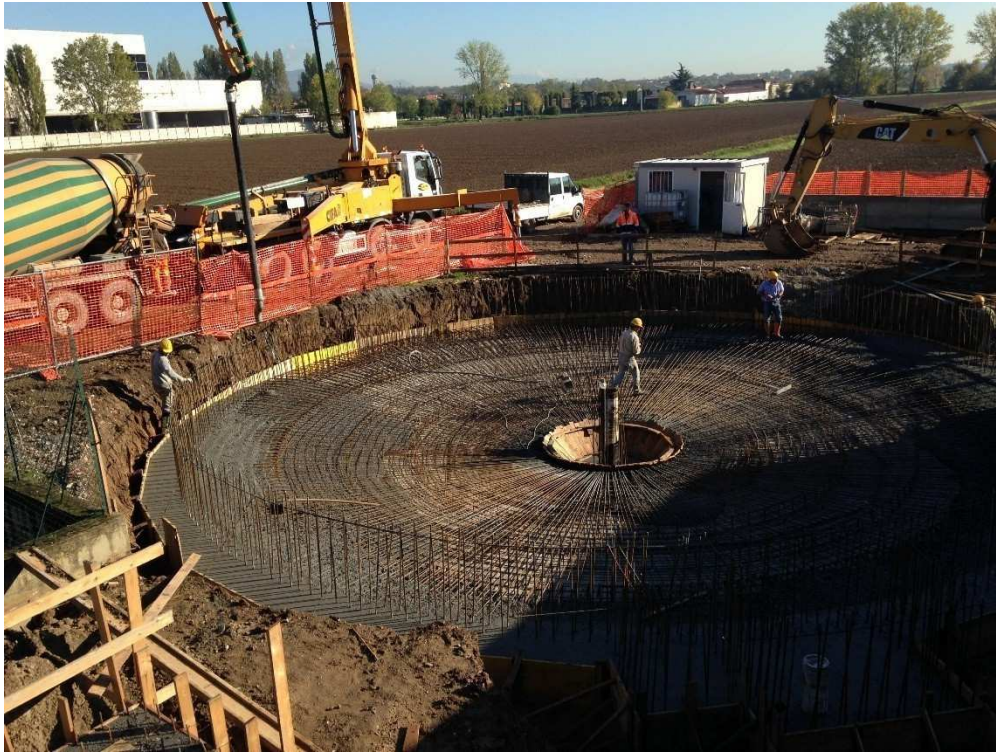
Foto 1 – Depuratore Azzano Mella – realizzazione platea nuovo sedimentatore finale
