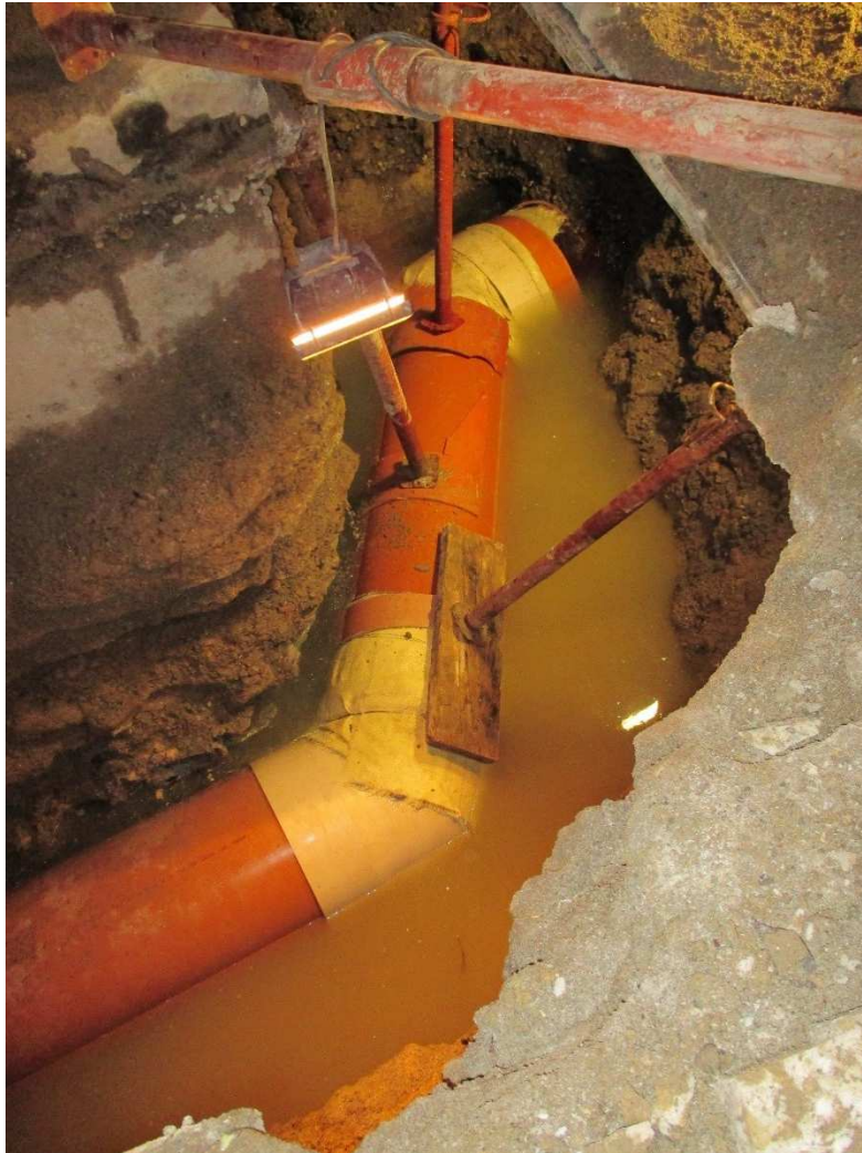
Foto 1 – Intervento sigillatura fognatura comunale Largo Dante - Iseo
