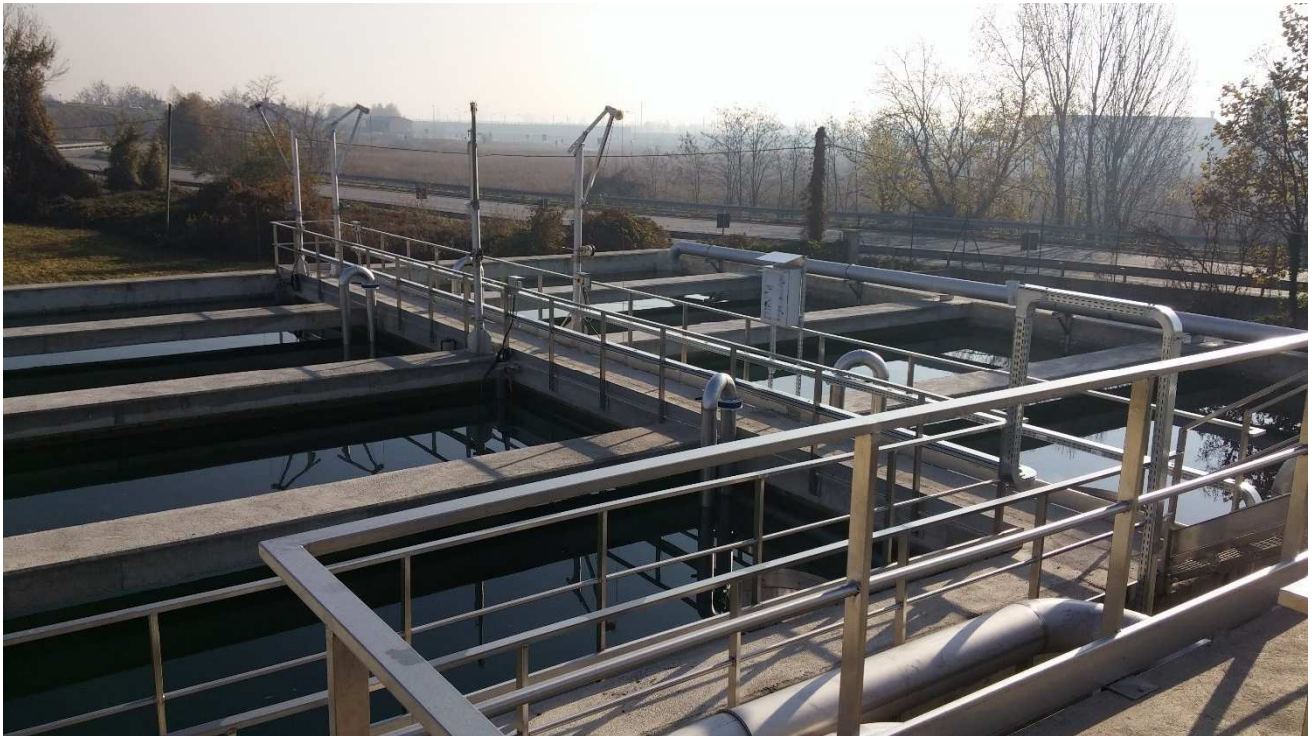
Foto 1 – Depuratore Chiari – ristrutturazione linea biologica n°2
